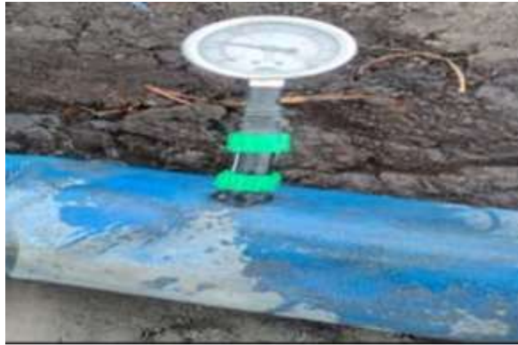
Figura 4. Toma de presión con un manómetro en la cabecera.
